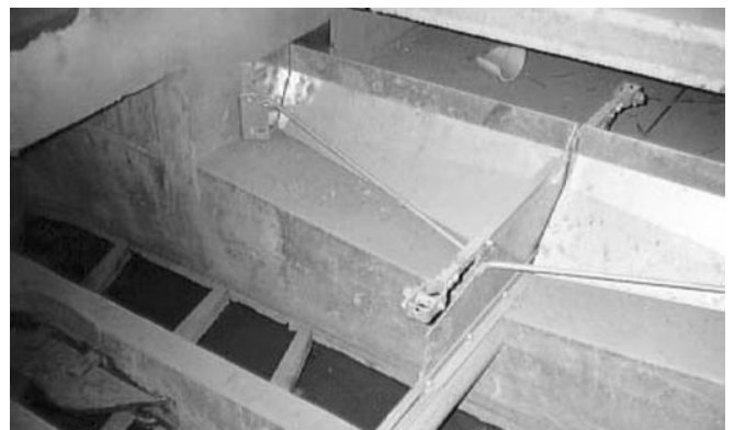
Figure 3 - Vue du dalot et du racloir en « V » installés au Michigan State University
