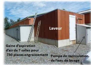
Prélèvement d'air en entrée et sortie du laveur pour mesure des concentrations en NH<sub>3</sub>, N<sub>2</sub>O et CH<sub>4</sub> par détection photoacoustique infra-rouge (Innova 1412)
